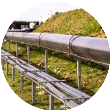
Captation de biogaz issu du stockage des déchets
