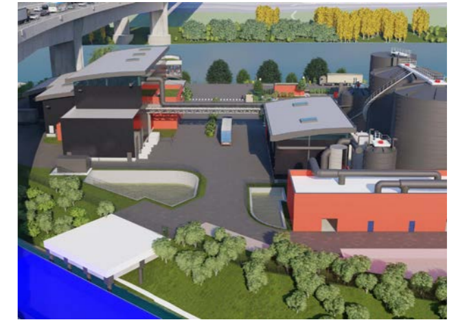
Methangasanlage für Bioabfälle der Stadt Paris
