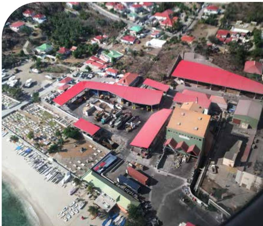
●●● L'usine se devait d'être ultra-moderne mais aussi résistante pour tenir face aux intempéries. « Nous avons conçu une usine capable de résister aux tremblements de terre et aux cyclones. Les charpentes, les massifs en béton... Tout doit être plus épais ! Quand le cyclone Irma a dévasté l'île en 2017, l'usine a été arrêtée et les équipes locales ont réussi la performance de la redémarrer en moins de trois jours », dévoile **Stéphane Bertrand**, directeur du développement Paprec Energies.
