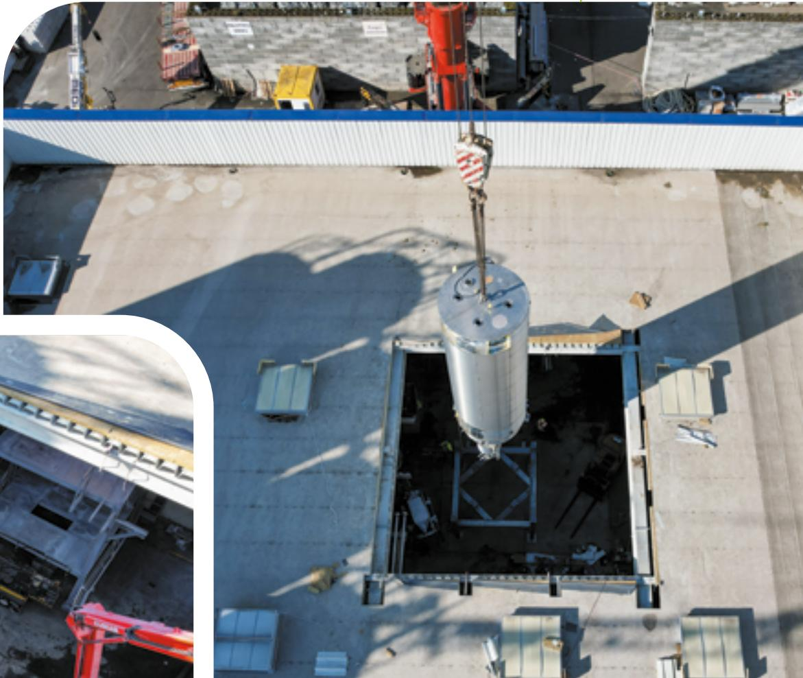
Utilizando un camión grúa, el equipo, que pesa varias decenas de toneladas, se eleva por la única vía de entrada posible: la cubierta. La instalación de un silo es una operación meticulosa.
