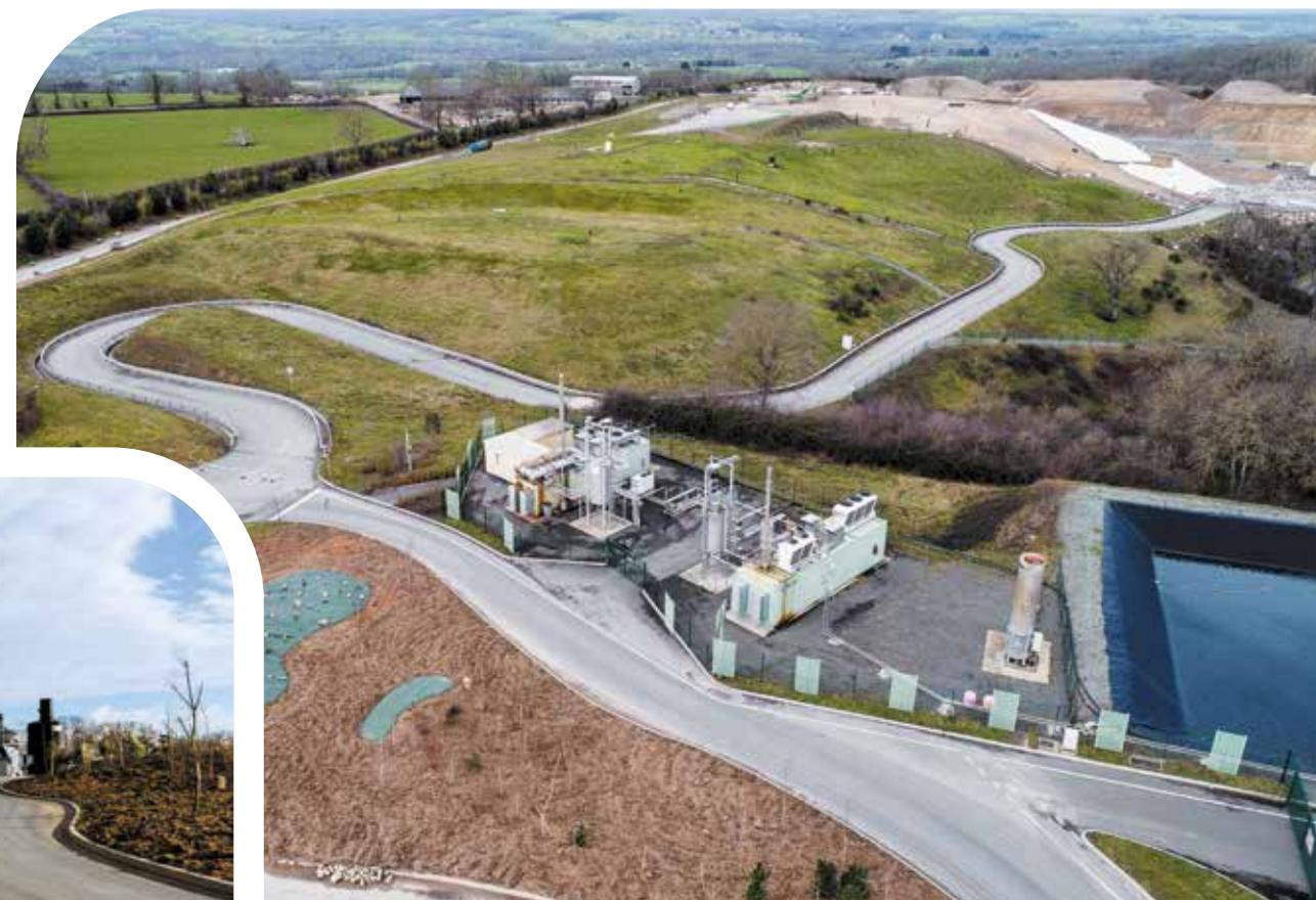
Der ISDND-standort Villeneuve (Allier) verfügt über Lagerbehälter und eine Anlage zur Rückgewinnung von Biogas aus Endabfällen.
