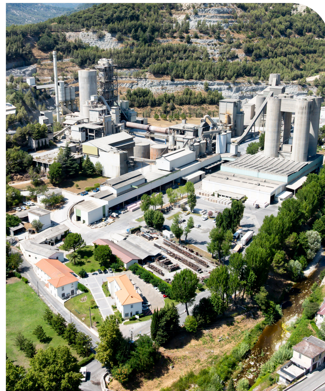
▼ La Grave de Peille cement plant
